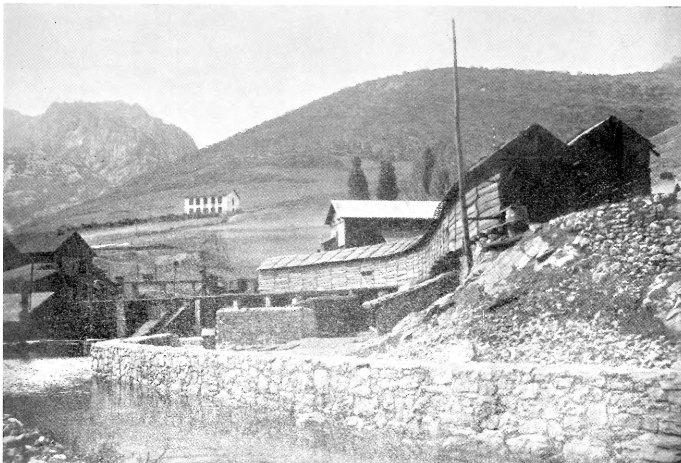
Paso cubierto para los vagones cargados entre el pie del plano y el Lavadero. Se ve por la derecha el Almacén; al frente la Estación de descargue del cable aéreo, al fondo, el Hospital de la Sociedad, a la izquierda el camino a las minas por la Hoz, y un pequeño depósito de agua con compuerta.
