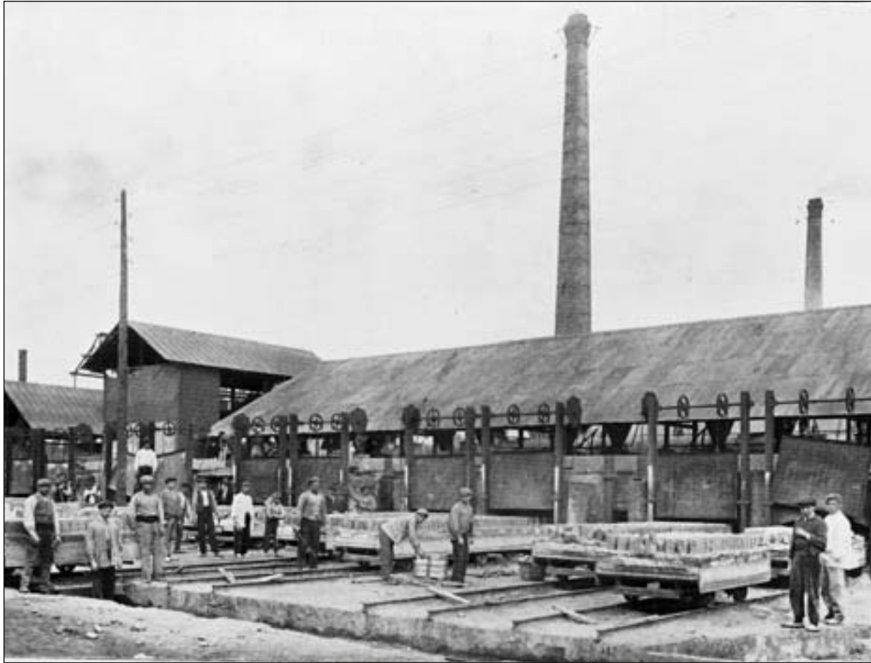
Planta de briqueteo. Aglomeración del mineral en forma de briquetas (Sagunto, 1912).
