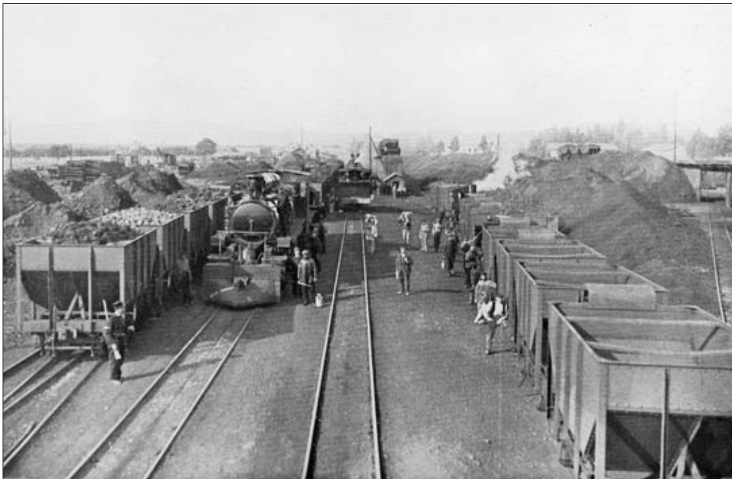
Vista parcial de la estación de llegada del mineral a Sagunto.
