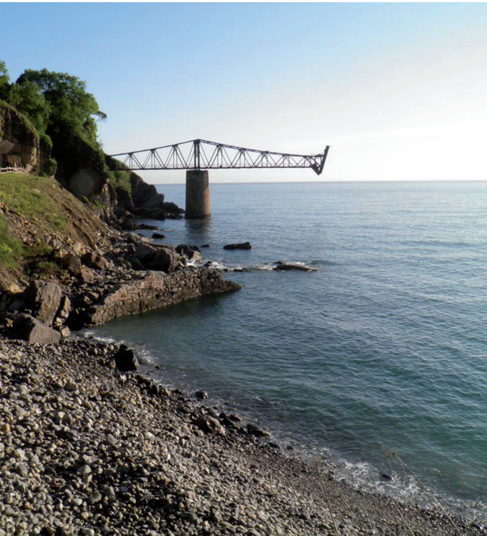
Cargadero de mineral de Dícido, Cantabria. Foto: Archivo IPCE
