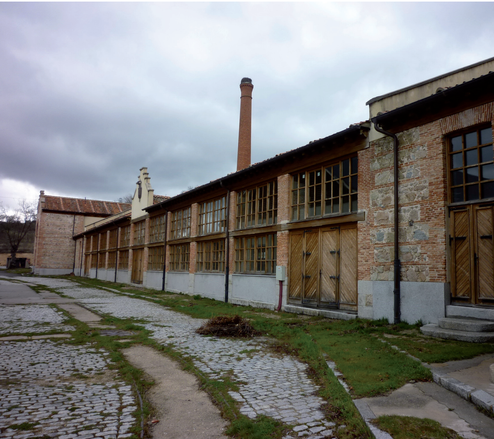
Real Aserrío Mecánico de los Montes de Valsaín (Segovia). Foto: Linarejos Cruz
