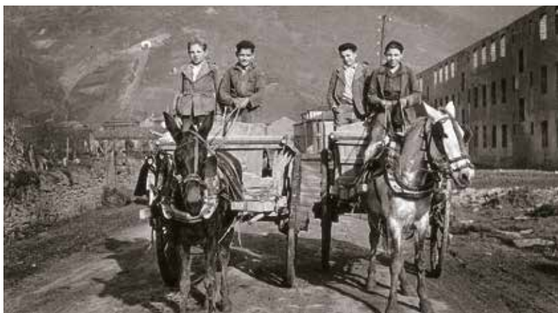
Guajes transportan en carros material para la construcción de viviendas obreras, fundamentales para el asentamiento de familias que llegaban en aluvión en busca de trabajo en las comarcas mineras
