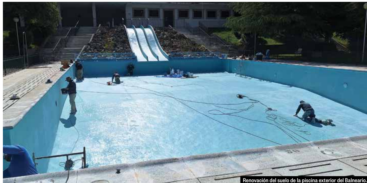
Renovación del suelo de la piscina exterior del Balneario.
