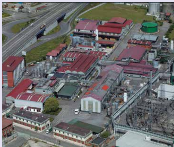
Instalaciones de Bayer en Langreo.
