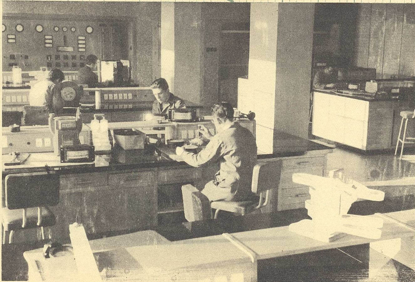
Sala de calibrado de aparatos de medida y control.
