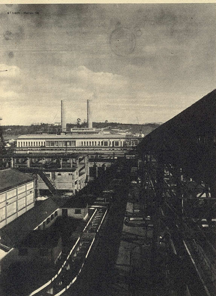
Aspecto parcial de la instalación Hornos de Acero
