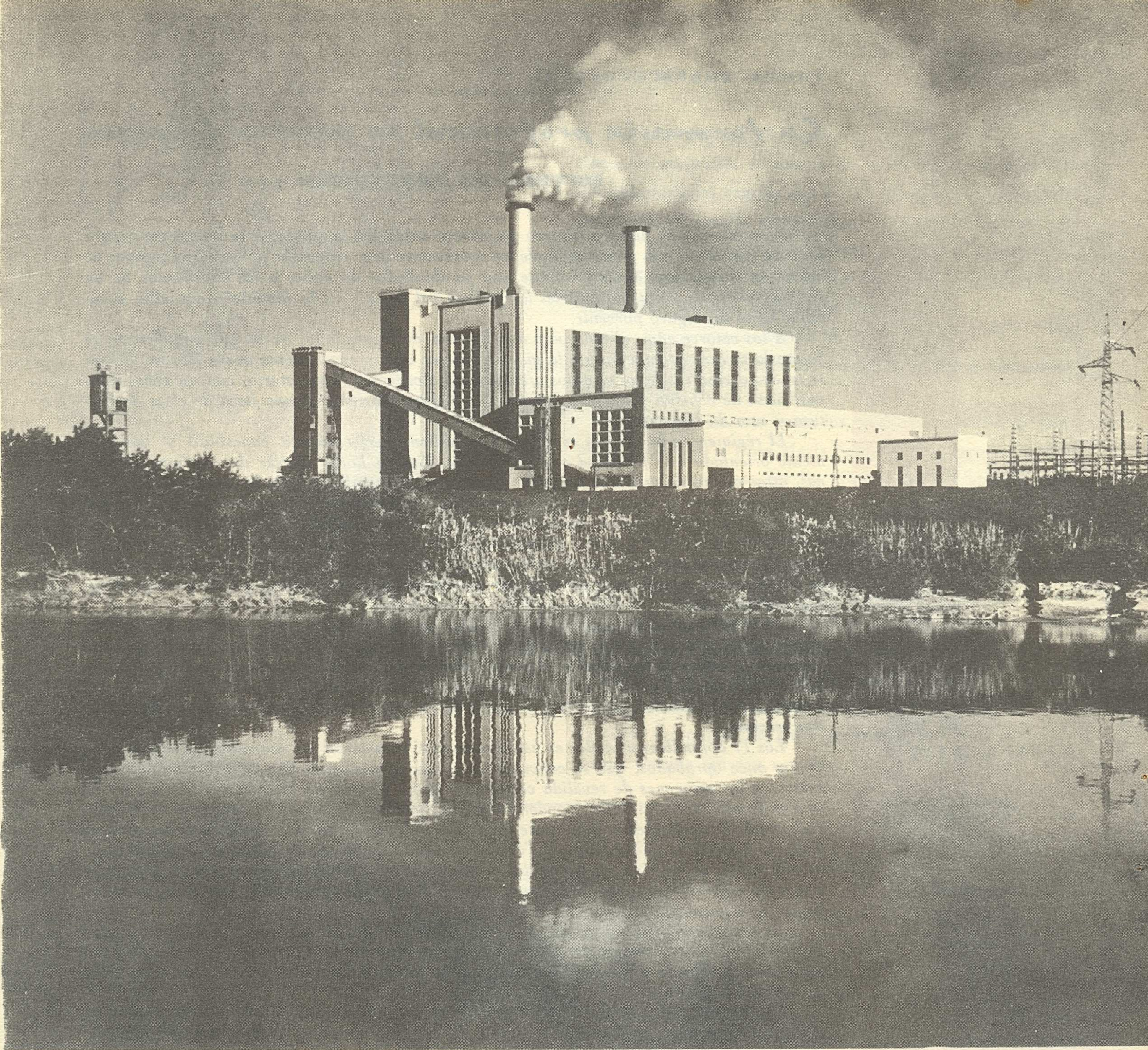
Central térmica de Escatrón
