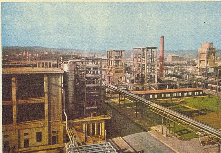
Hornos de Cok. Instalación de Subproductos.
