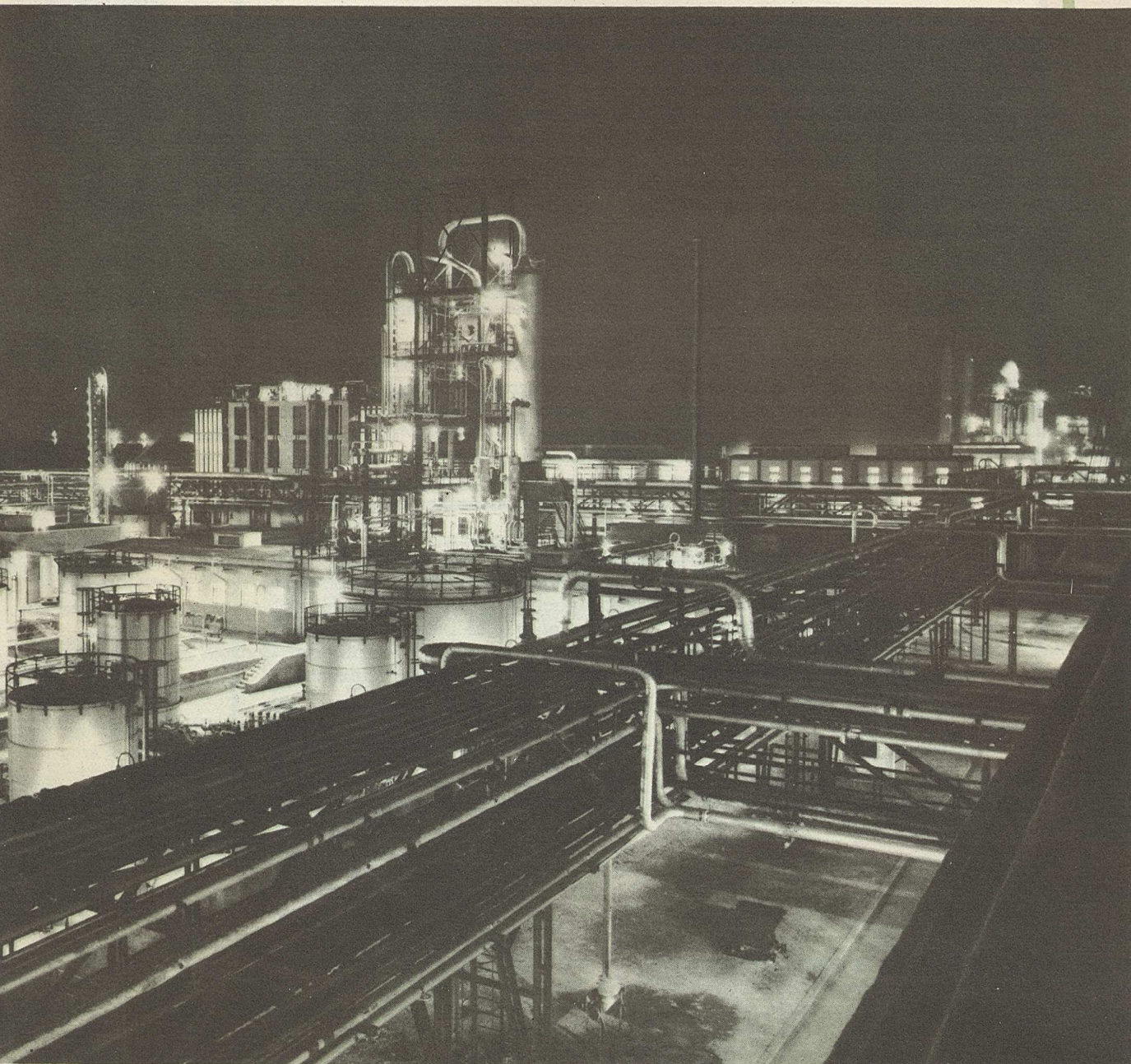
Vista general de la Sección de Refino en la Empresa Nacional «Calvo Sotelo» de Puertollano.
