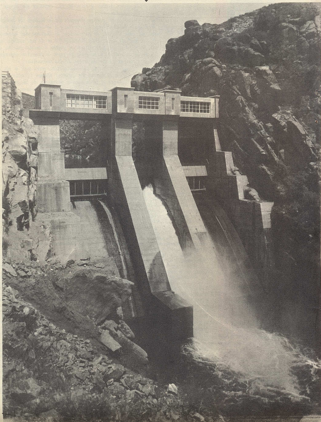
Fuente del Azufre.-Aliviadero, desagüe de fondo
