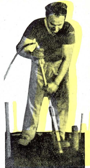
Atacar con martillo neumático
