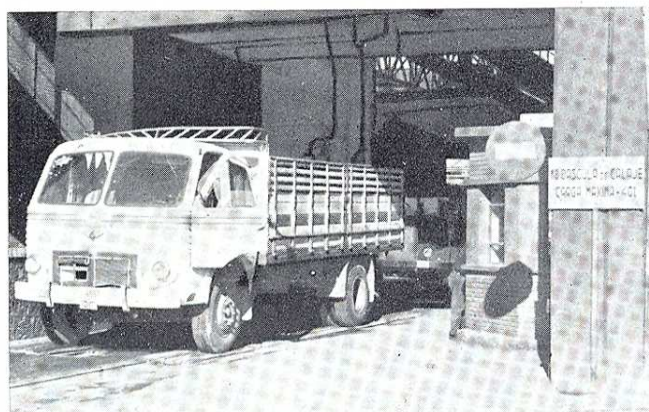
Pesaje de un camión en báscula de plataforma
